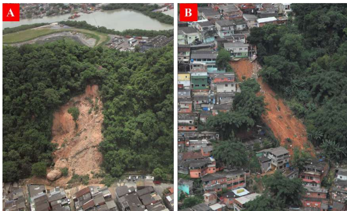
Figura 5. Fotos obtidas em 04/03/2020 mostram: A, escorregamento no Ilhéu Alto; e B, escorregamento entre as ruas 1 e 8, nos morros Pacheco e Penha.
