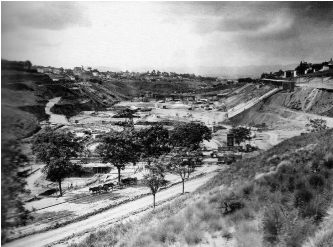
Figura 7. As obras em andamento, com as arquibancadas sendo “acomodadas” nos flancos do vale.
