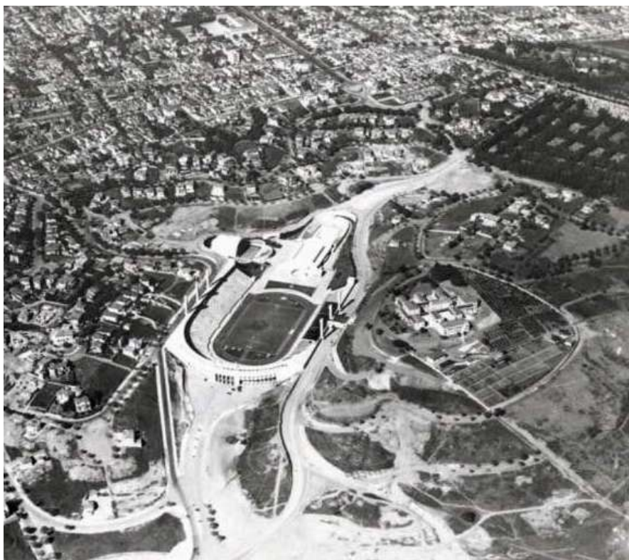
Figura 10. As obras de construção do Estádio do Pacaembu já praticamente concluídas. Notar que as conformações geomorfológicas do terreno natural original foram essencialmente respeitadas e mantidas.
