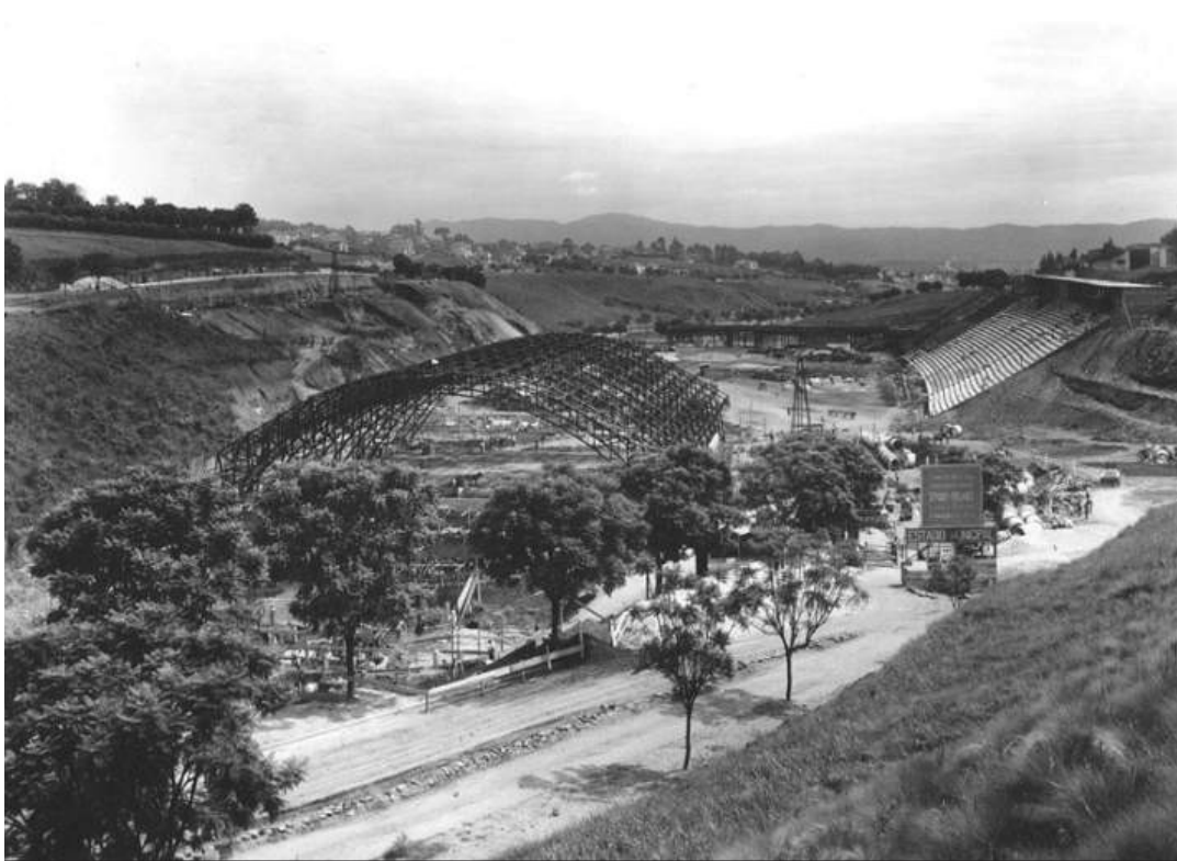
Figura 9. Foto panorâmica mostrando o avanço das obras do estádio, identificando-se a estrutura da cobertura do ginásio e a arquibancada lateral direita já assentada sobre o talude da gruta. Ao fundo, a Serra da Cantareira.
