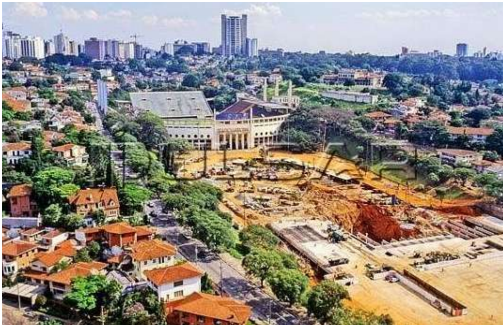
Figura 13. Obras do piscinão na Praça Charles Miller.
