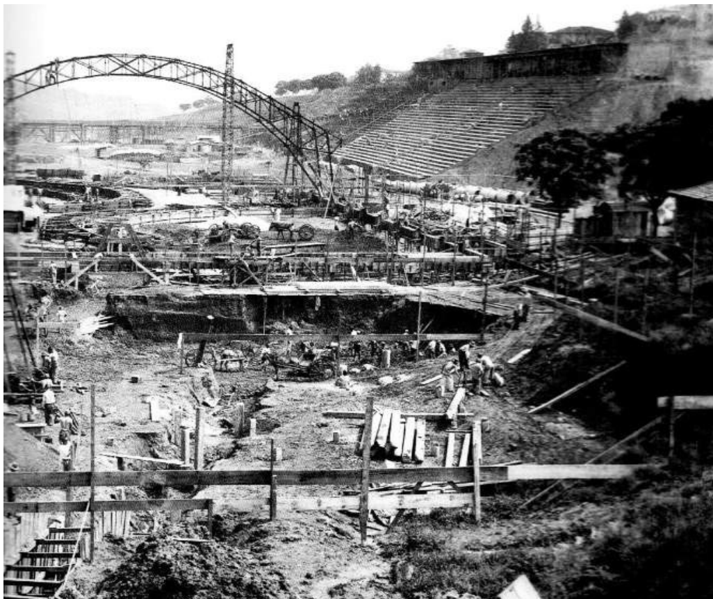
Figura 8. Detalhe do canteiro de obras.
